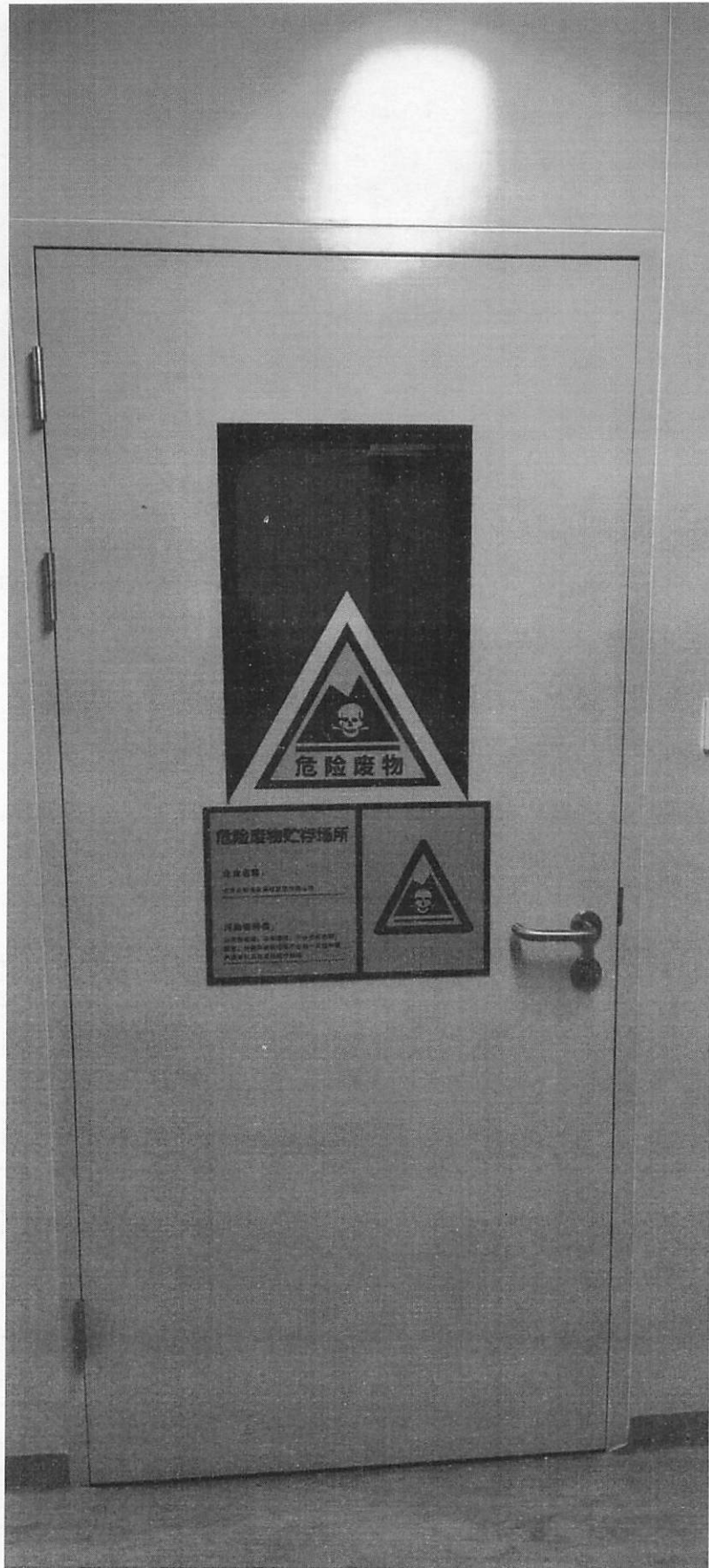
图 4.1-7 危废暂存规范化情况
