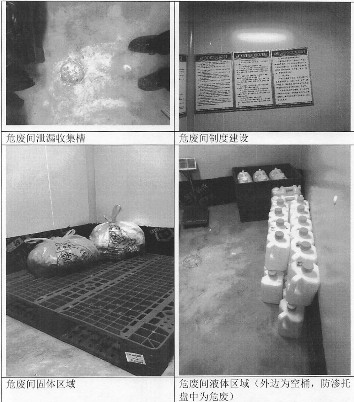
图 4.1-4 危废收集及暂存间建设情况
